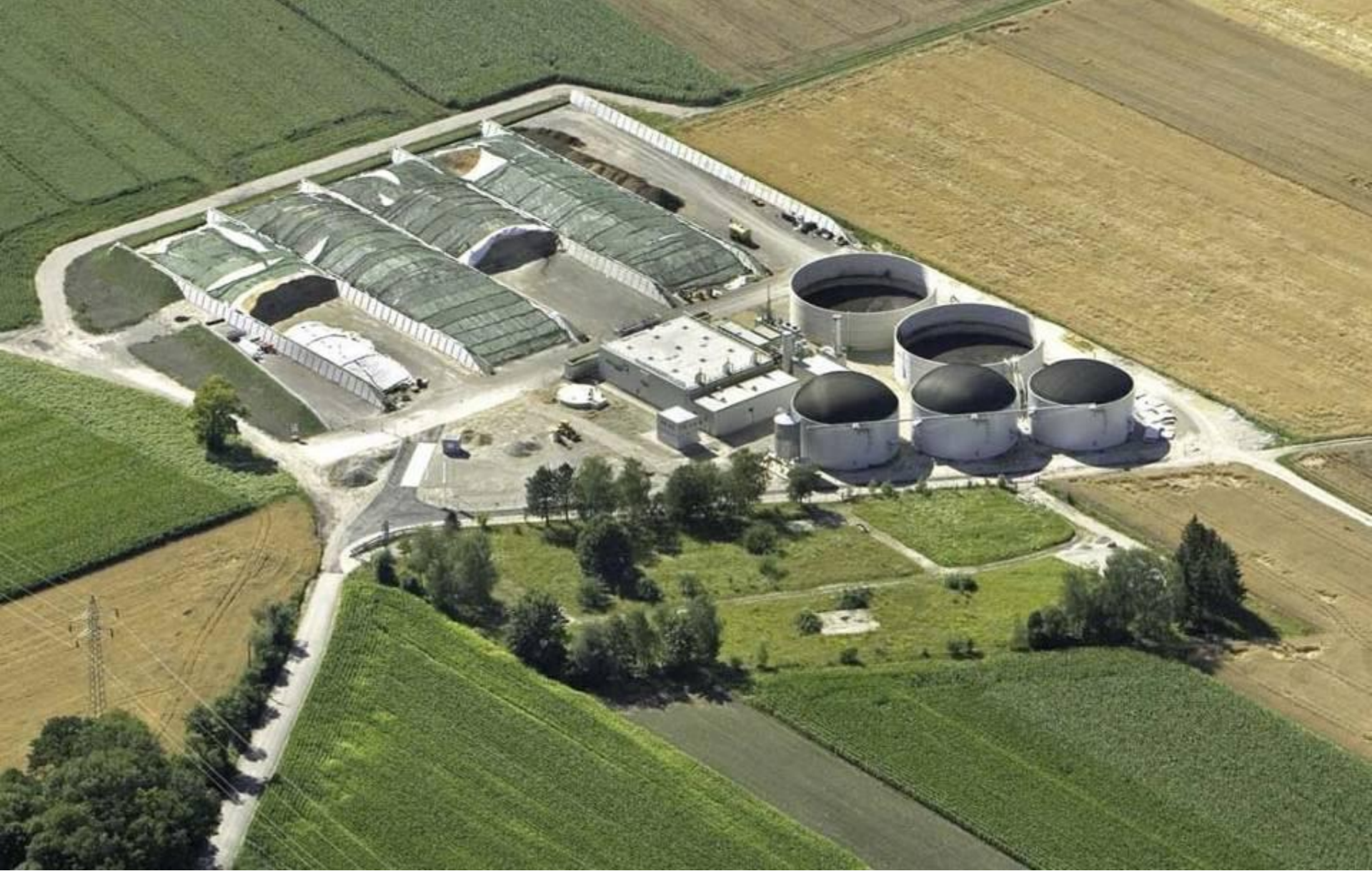
(1) ドイツのバイオガスプラント
