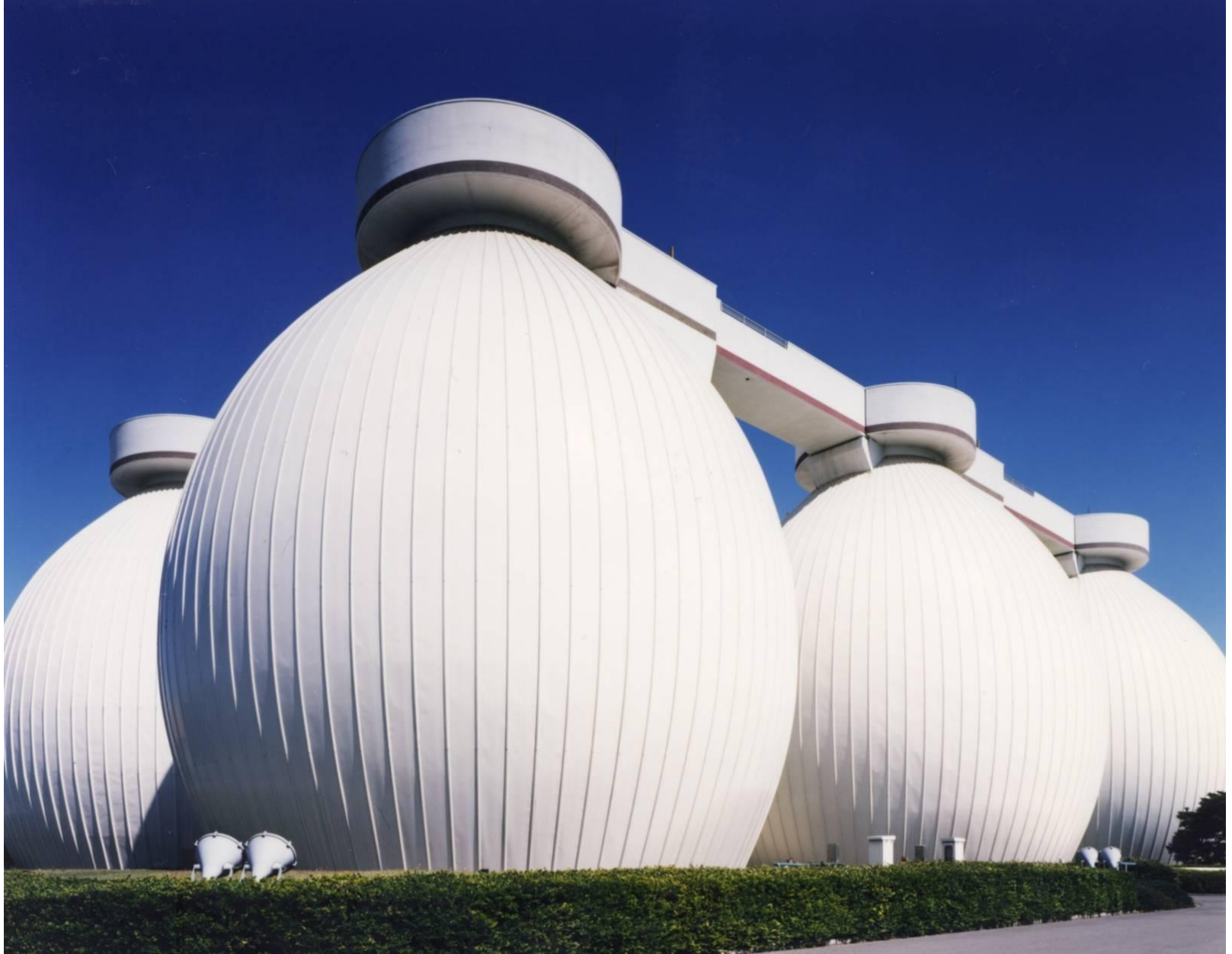
北部汚泥資源化センター 1987年9月開始
