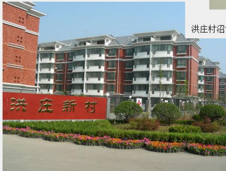
洪庄村农民公寓总占地80亩，建筑面积8.42万 m^2 ，可安置960户居民入住。工程分为二期建设，第一期工程已完工，村民已入住。
