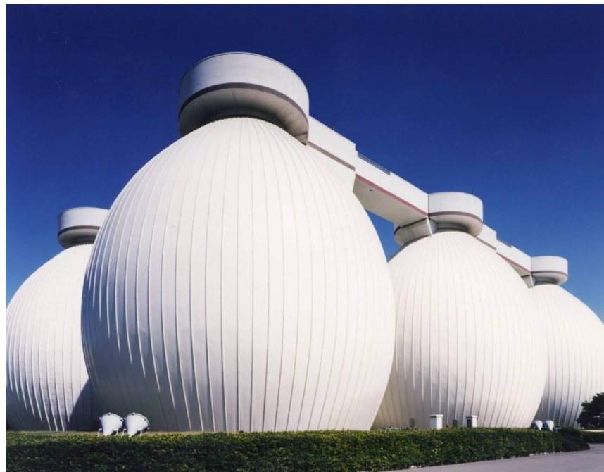
下水汚泥からバイオガス を回収する消化槽
